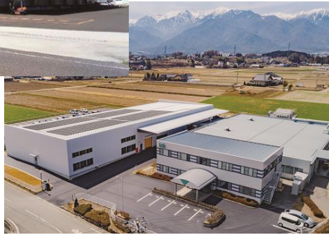
駒ヶ根工場・駒ヶ根物流センター(長野県)
