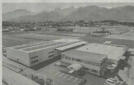
太陽光パネルを設置した駒ヶ根工場
